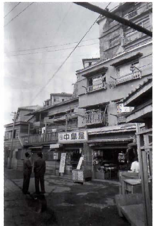
[1952] 木造の商店が並ぶ南部商店街。これらは元遊郭であったというが、その後火災で焼失、その跡にRCの31号棟が建てられた。右上のRCは25号棟。
